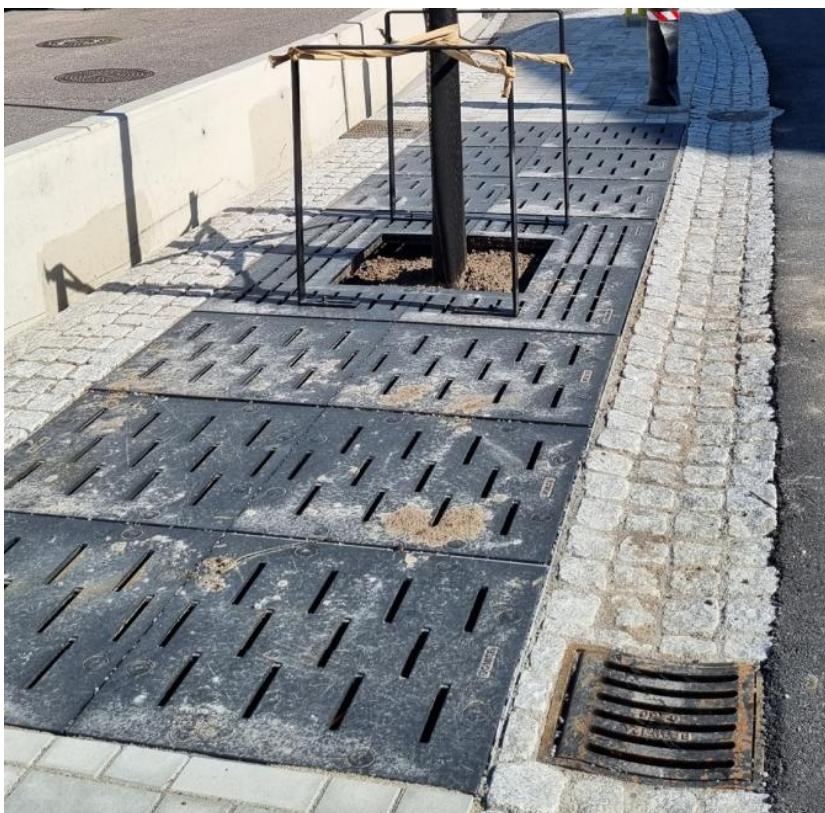
Figur 54. Exempel på utformning av regnbädd med hårdgjord täckning (Edge, Göteborgs stad, 2024).
